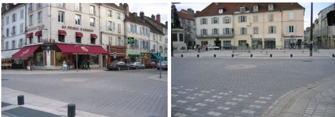
Figura 113: Intersecție partajată (“shared-space”), Lons le Saunier - Franța
