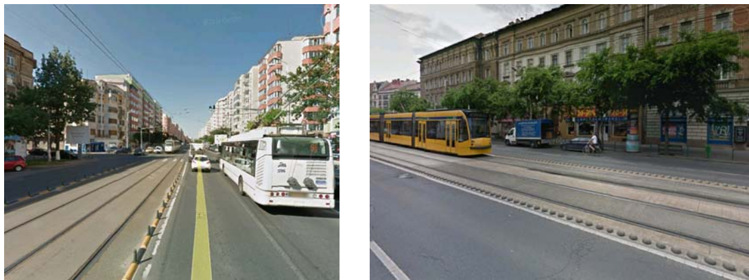
Figura 121: Soluții de amenajare a tramvaiului în cale proprie în București (stânga) și la Budapesta (dreapta). Sursa: Google Earth
