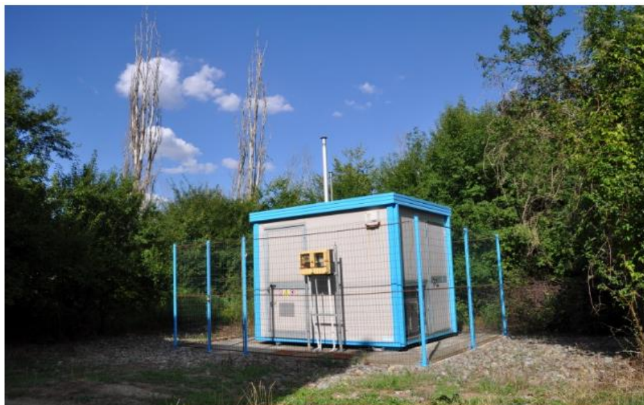
Figura 2-27 Stația automată de monitorizare a calității aerului Breasta DJ5
