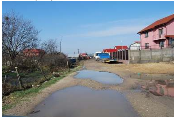
Foto 21.1 Gropi cu apă în structura rutiera din balast
