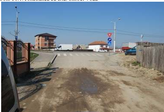
Foto 58.1. Jonctiunea cu Bld. Știrbei Vodă
