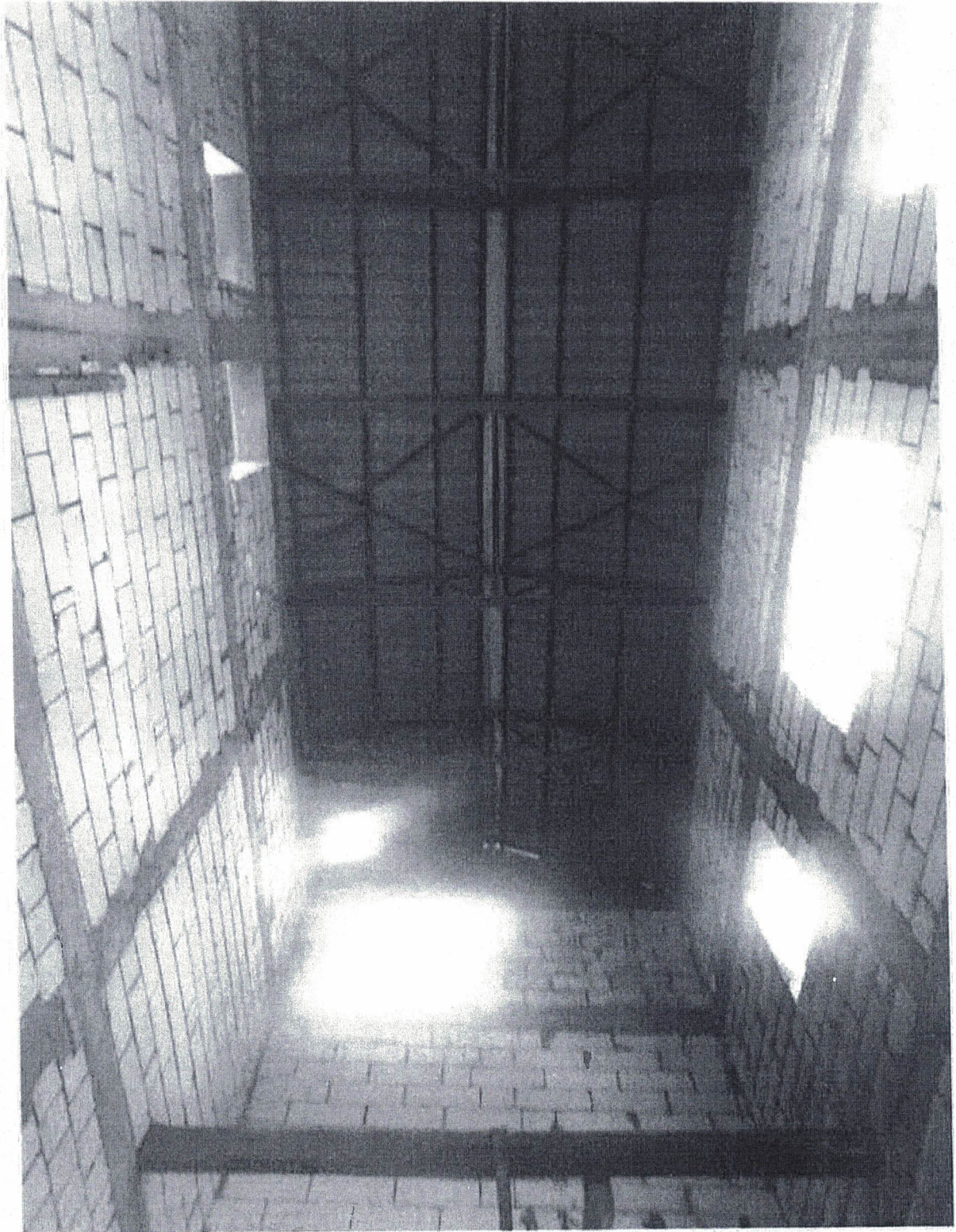
Foto nr. 3. Acoperiș metalic
