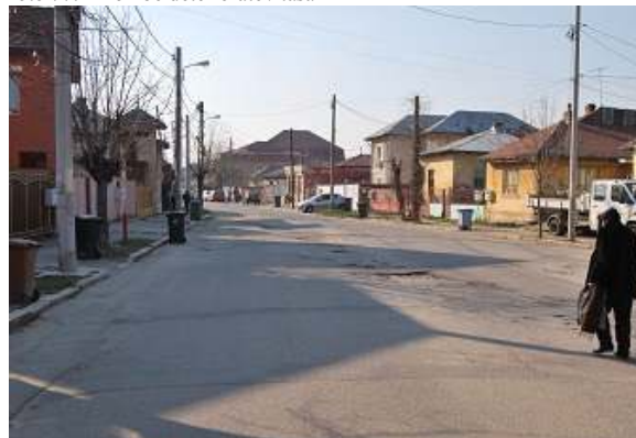
Foto 77.4 Plombe deteriorate / tasari
