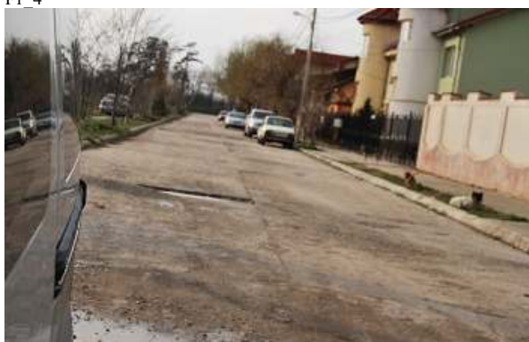
Foto 4.1 vedere spre str.Potelu, din zona sondajului FI_4
