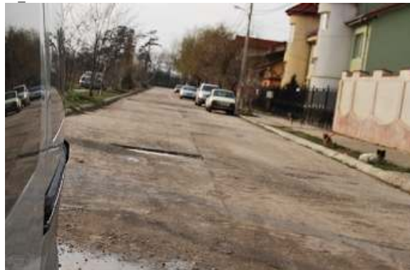
Foto 52.1 vedere dinspre str.Potelu, zona sondajului F2_52
