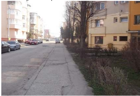
Foto 27.4 Degradari zona pietonală
