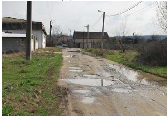
Foto 76.4 Degradari carosabil asfalt
