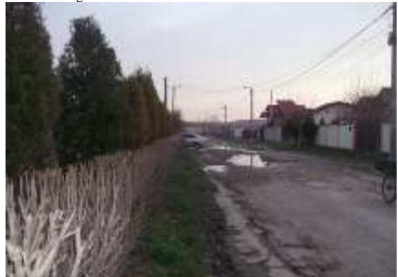
Foto 76.4 Degradari carosabil asfalt
