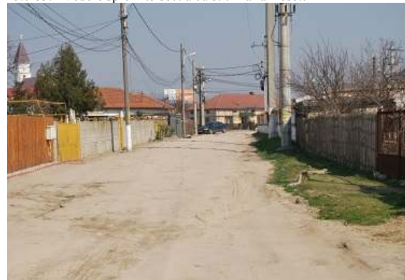
Foto 83.2 Vedere spre intersecția cu str. Maria Rosetti
