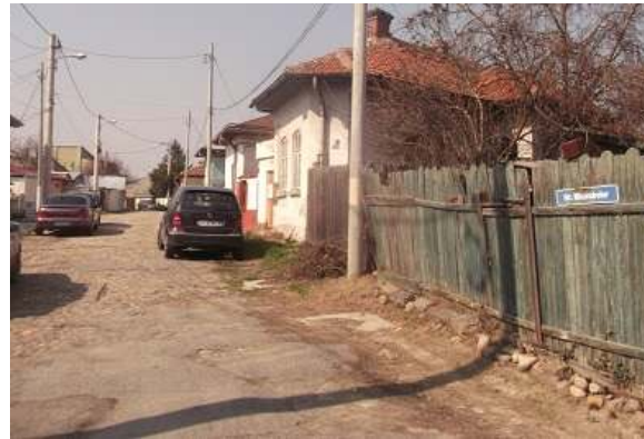
Foto 45.2 Plombe de asfalt
