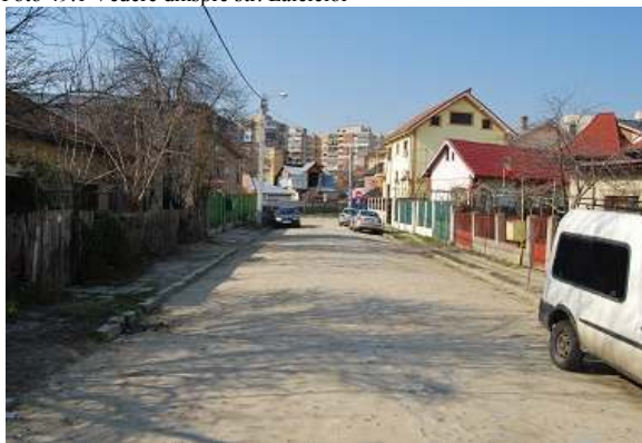
Foto 49.1 Vedere dinspre str. Lalelelor
