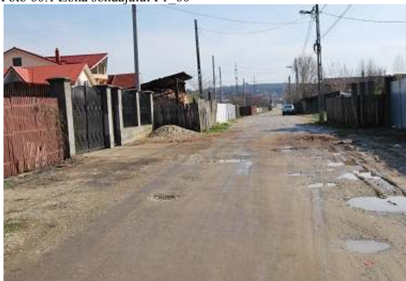
Foto 60.1 Zona sondajului F1_60
