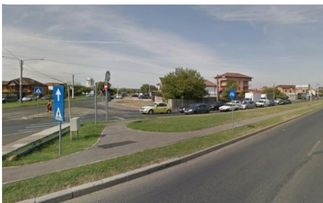
Figură 2-84 – Pista de biciclete - Strada Râului
